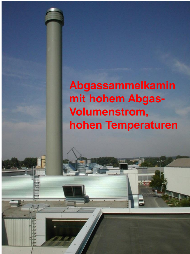
Abgaskamin mit Integriertem Schalldämpfer
